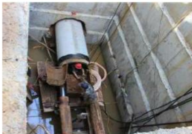
(e) 深基坑和地下管沟
